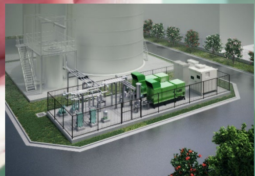
消化ガス発電システム
