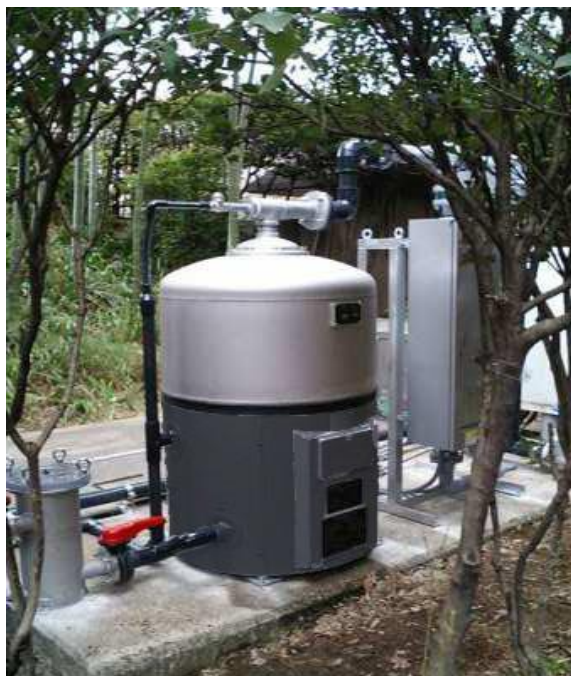
設置例(除塵器、紫外線殺菌装置装備)
